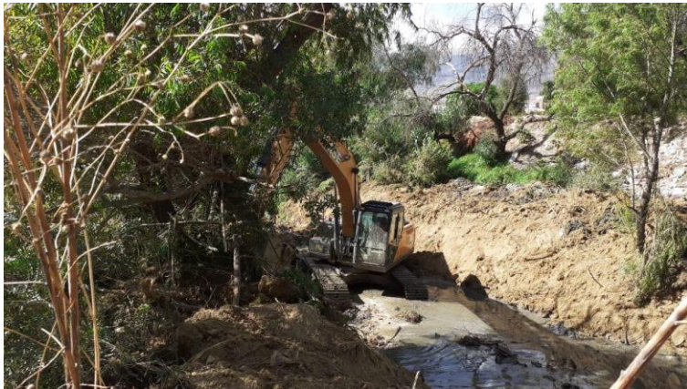
FOTO 7: Dragado con maquinaria pesada Rio Maylanco sector OTB 27 de Mayo del Distrito-2.
