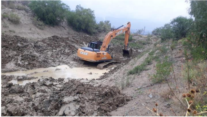
FOTO 5: Dragado con maquinaria pesada Colmatador 1 del Distrito-4.
