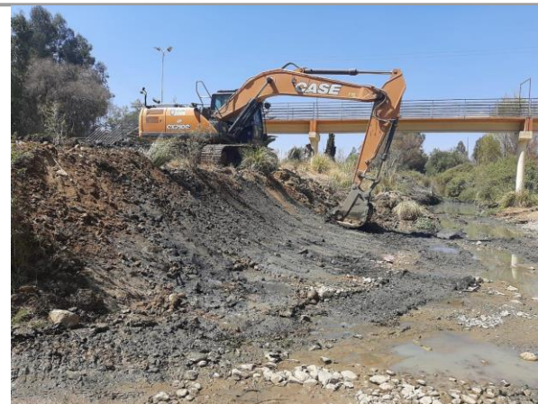
FOTO 12: Dragado con maquinaria pesada Rio Maylanco setor Piscina Olímpica del Distrito-1.
