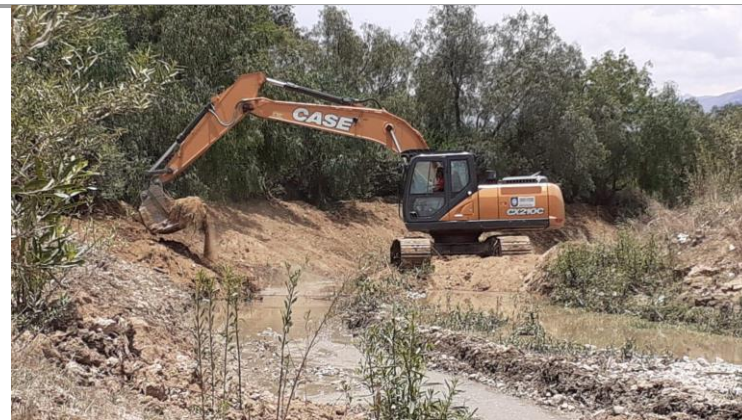
FOTO 10.- Dragado con maquinaria pesada Rio Maylanco setor Esmeralda Sud aguas abajo del Distrito-4.
