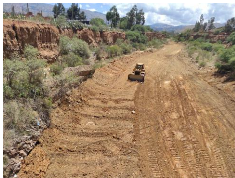
FOTO 1: Canalizado de canal Pluvial sector Tacoloma perteneciente al Distrito-1.
