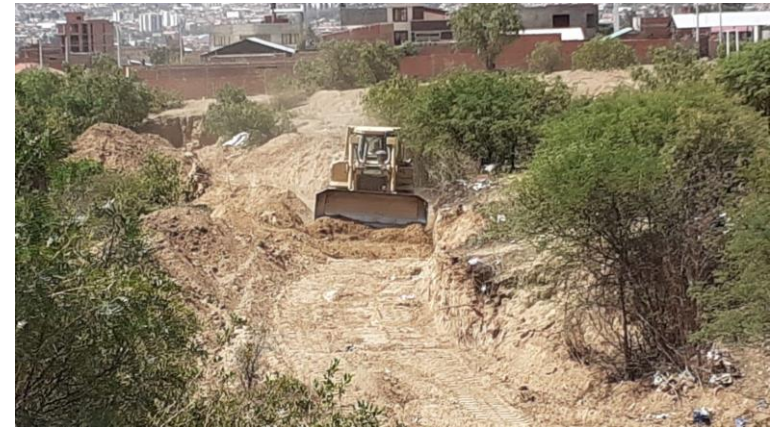
FOTO 8: Dragado con maquinaria pesada de la Torrentera La Viña del Distrito-6.
