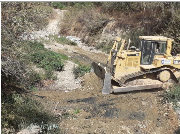
FOTO 11: Dragado con maquinaria pesada Rio Maylanco setor Esmeralda Sud aguas arriba del Distrito-4.
