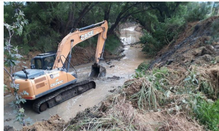
FOTO 4: Dragado con maquinaria pesada Rio Maylanco Sector Copelme Distrito-2 y Distrito-6.
