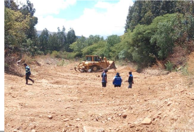
FOTO 6: Dragado con maquinaria pesada Torrentera Aguada del Distrito Rural Lava Lava.
